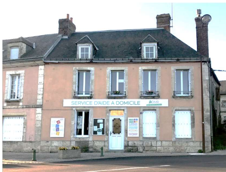
Les bureaux de l'antenne de l'ADMR, désormais installés au carrefour de la route d'Echauffour
