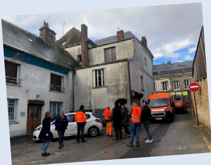
Le 22 janvier avait lieu la réunion préparatoire aux travaux de démolition avec les représentants de la Commune, d'EPFN, de l'entreprise de démolition ainsi que des représentants de la Poste
